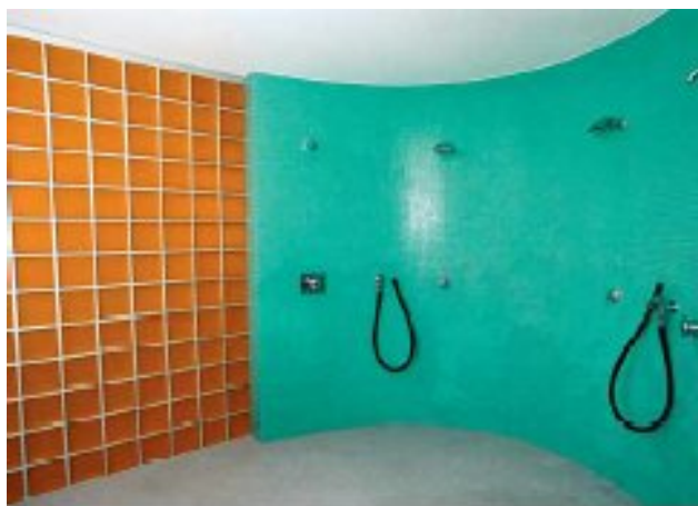
Bilde 5: Glassmosaikk på buede dusjvegger laget av armerte polyesterplater.
