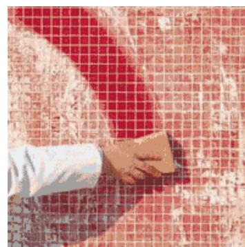
Bilde 4: Godt resultat oppnås ved å bruke hvite, finkornige fugemasser uten kvartssand.
